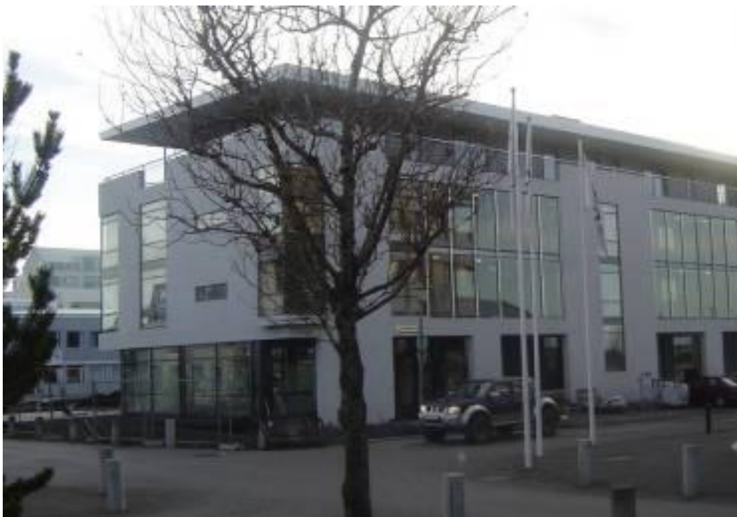
Nýleg bygging í miðbæ Hafnarfjarðar
