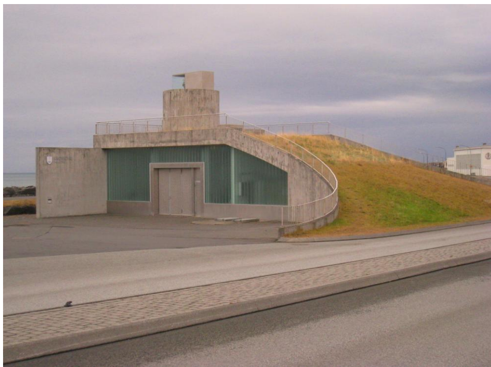
Nýleg dælustöð við Norðurgarð
